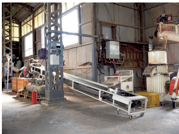
搬送冷却用ベルトコンベア
