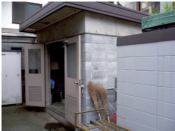
ペレットボイラの建屋
